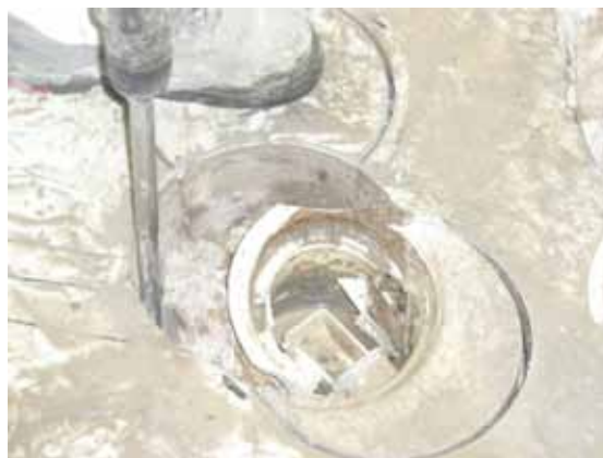
Demontering av golvvbrunn och betongdelar.
