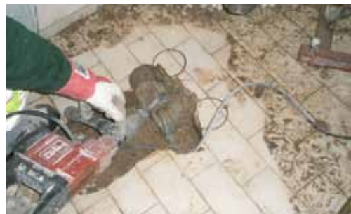
Frambilning av rörände med muff.
