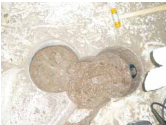
Kärnbrörningen klar. En gumminippel har monterats i rörände.
