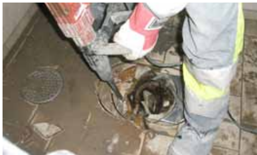
Borttagning av kärnborrade hål-i-hål segment.
