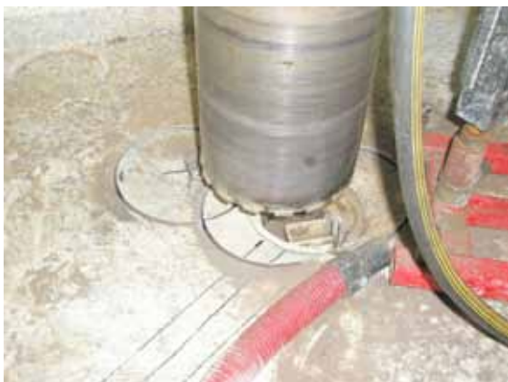
Kärnbrörning för demontering av golvvbrunnen.
